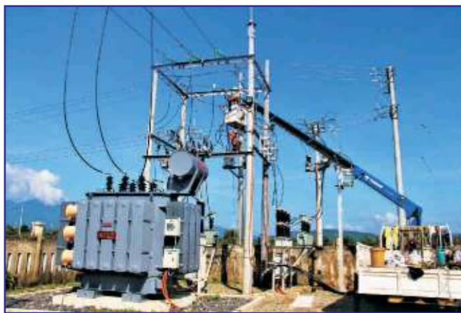
Một trạm biến áp (12MVA) được xây dựng mới tại Khánh Vĩnh
