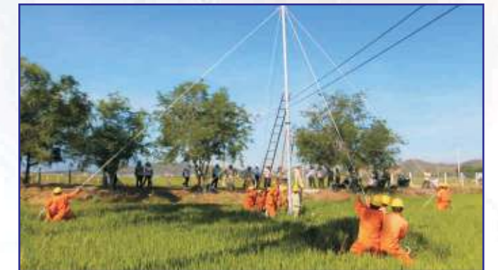
Diễn tập PCTT - TKCN dựng trụ bằng phương pháp thủ công
