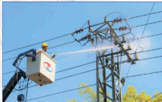
Vệ sinh lưới điện đang mang điện trên đường Yersin (Nha Trang) bằng công nghệ Hotline
