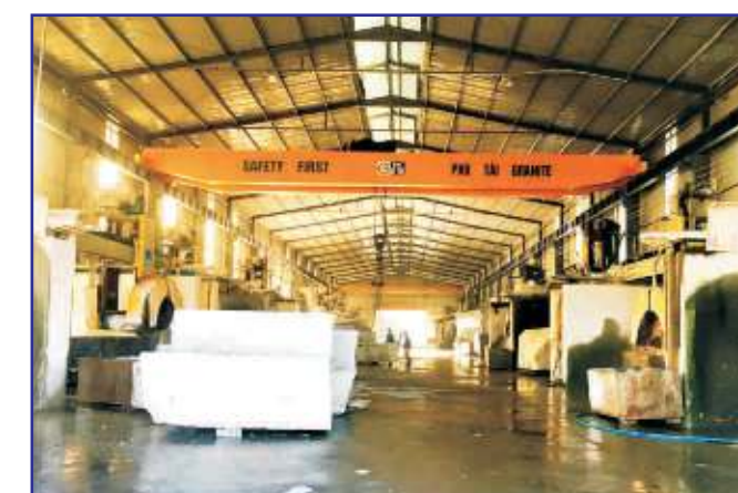
Nhà máy SX đá Granite (Cty CP Phú Tài - CN Khánh Hòa) tại Vạn Ninh
