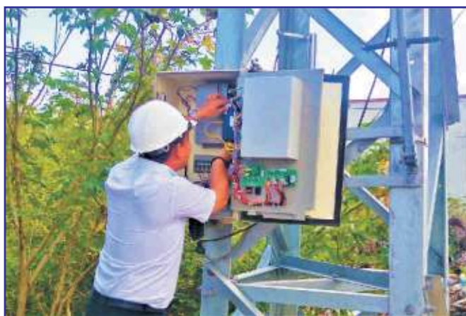
Lắp đặt thiết bị Router 3G
