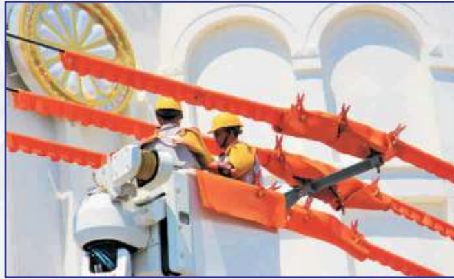
Sửa chữa lưới điện cao thế đang mang điện bằng công nghệ hotline
