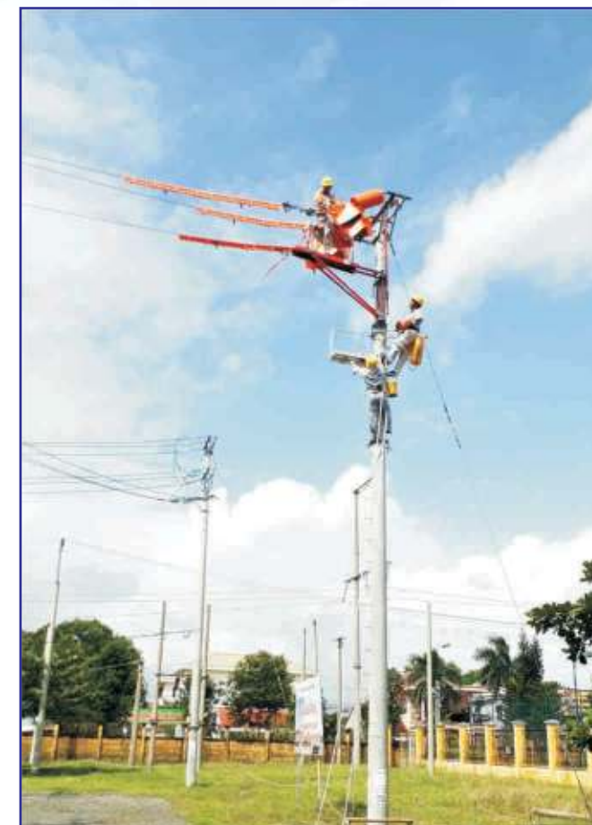
Thực hành thi công sửa chữa hotline với bộ đỡ Platform tại E31
