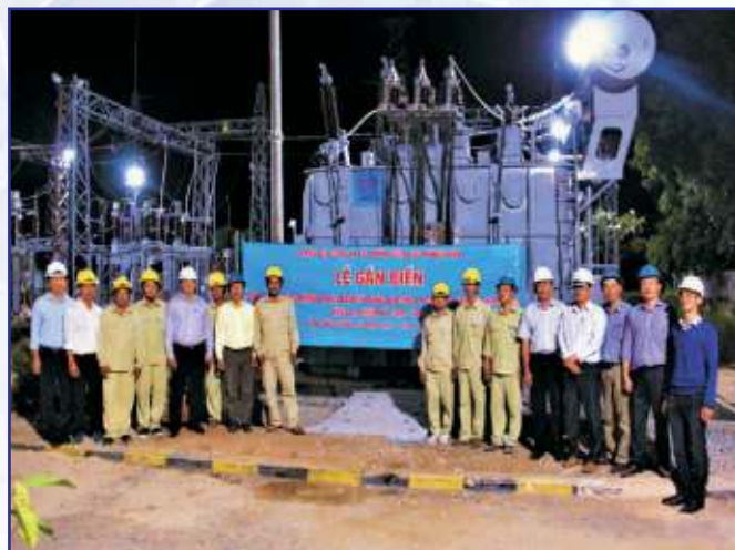
MBA T2 110kV EVG đã đóng điện thành công tối ngày 20.12.2019
