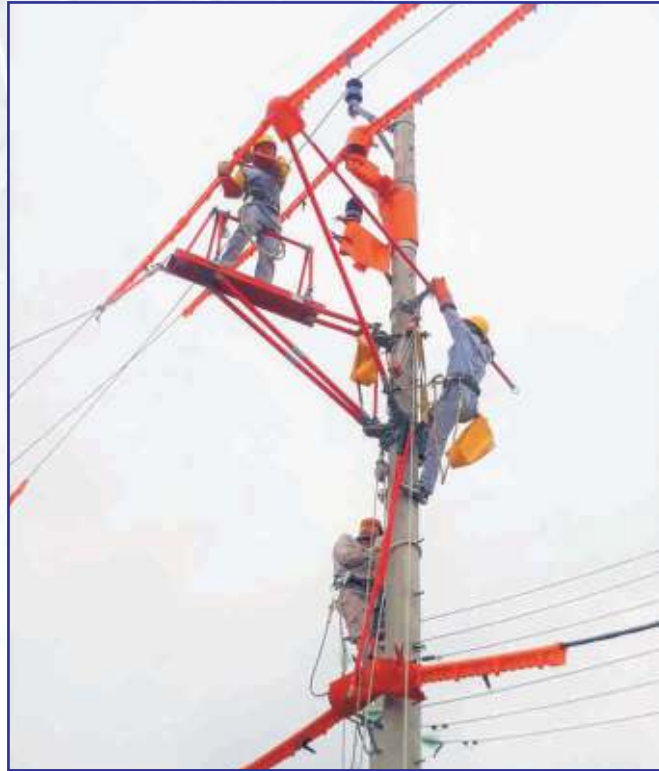
Thực hành thi công sửa chữa hotline với bộ đỡ Platform tại E31
